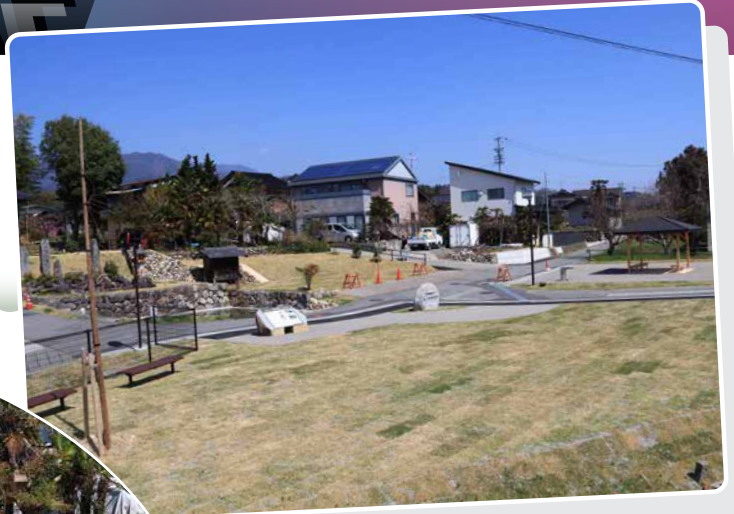
完成した「清水エリア」の全貌
